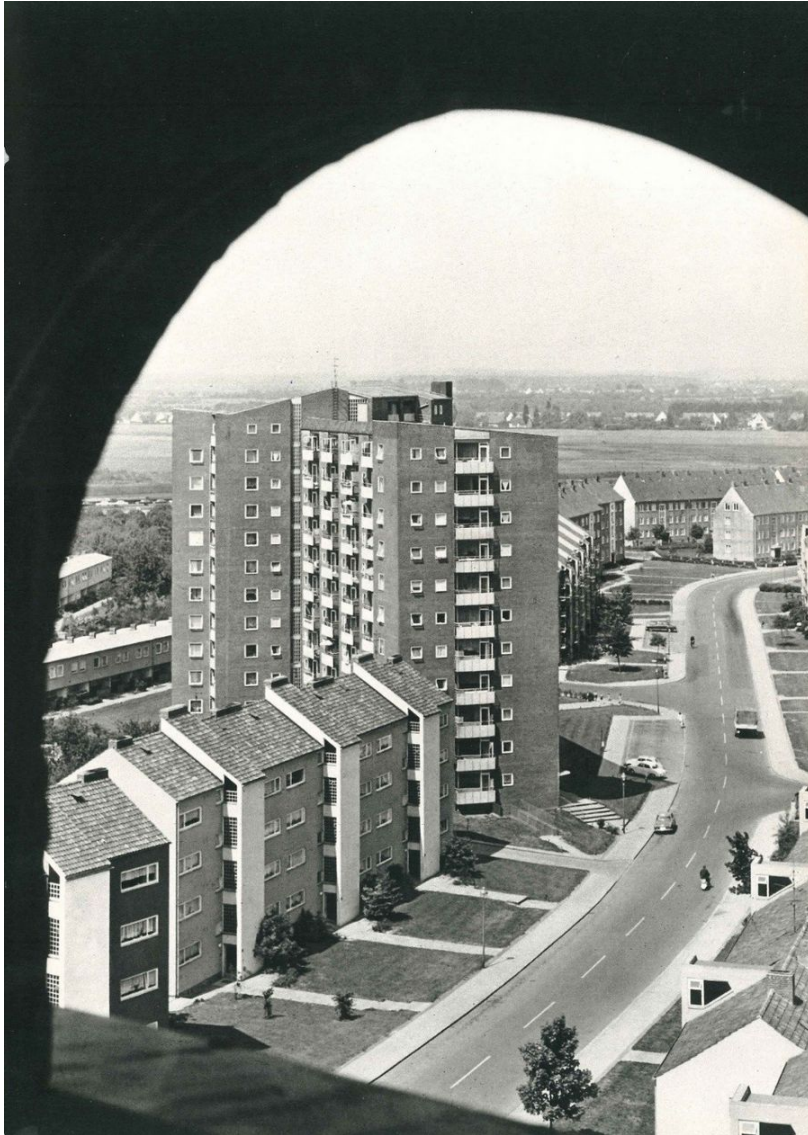
Fig. 68: Багатоповерхова будівля-домінанта як опорна точка міського простору у будівництві населених пунктів та помешкань 50-60-х рр.
