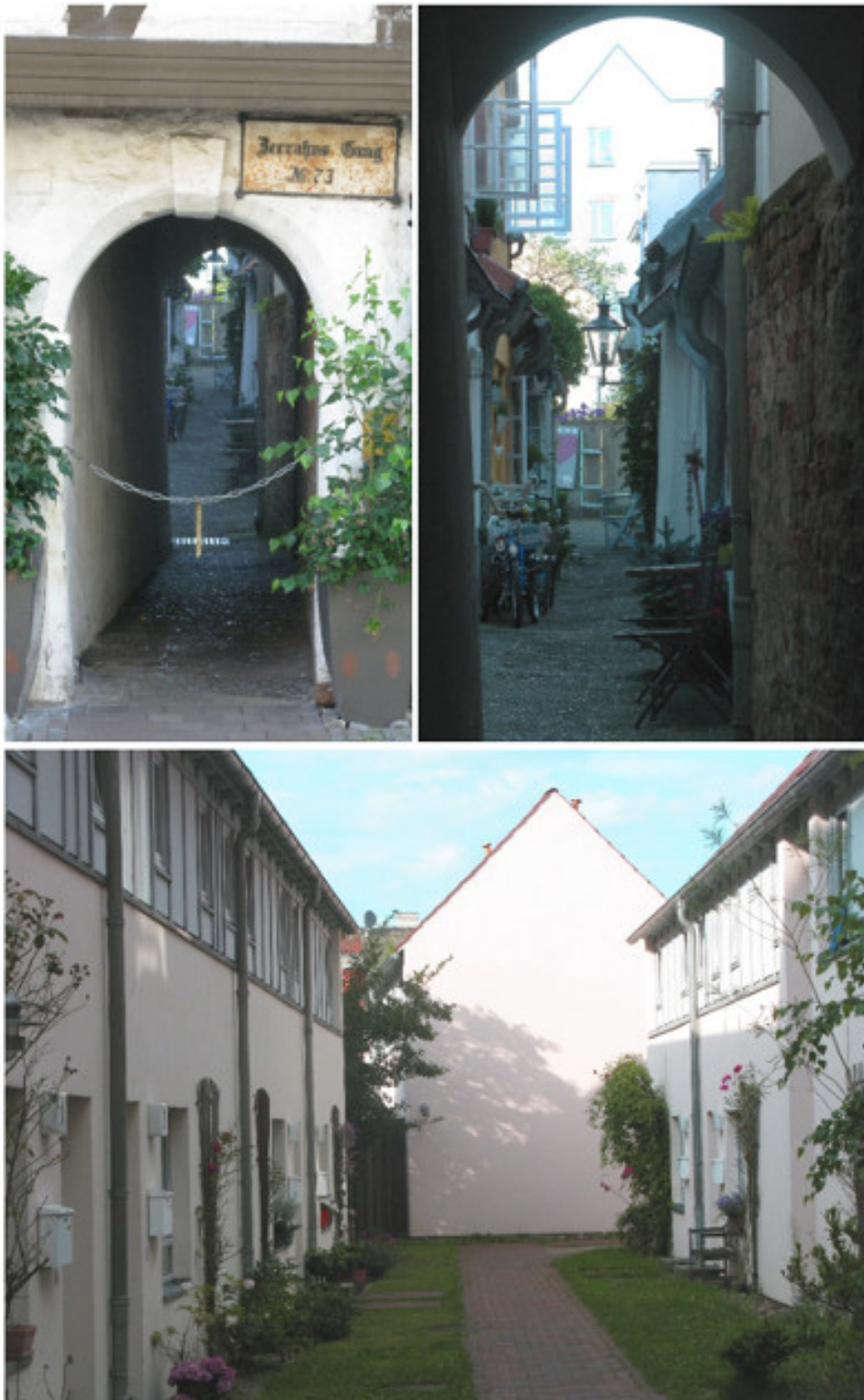
Fig. 60: Прохід для доступу через парадний будинок на вул. Енгельсгрубе ("зліва зверху") та прохід крізь поздовжню забудову „Zerrahns Gang“ із закритими, з обох сторін збудованими рядами будинків, "справа зверху"; схожа на Gang нова забудова на вул. Фішергрубе позаду нових парадних будівель з чисельнішими, зміщено розташованими невеликими будинками рядової забудови та утвореними малими дворами (усі фотознімки 2017 року), "внизу".
