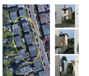
Fig. 95: Вул. Ельсвігштрассе (Любек): три задні будівлі)..... 158
