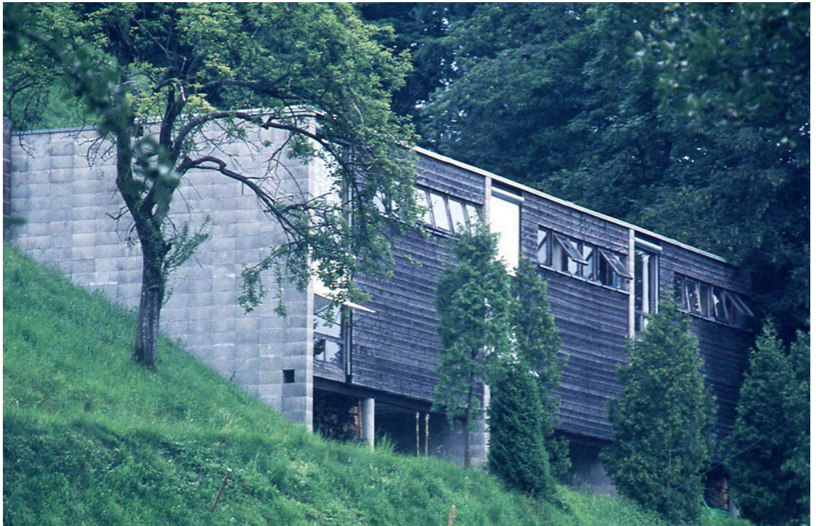
Fig. 132: Північно-західний вид (фото № 353-24)
