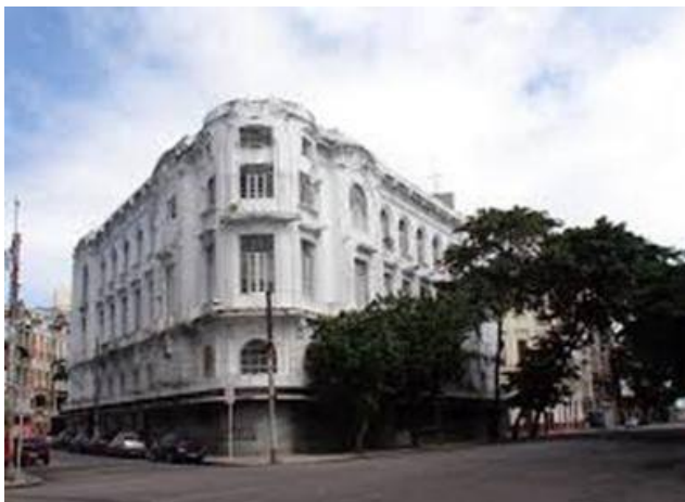
Fig. 21: “Зображ. будівля станом на 2008 рік; архітектори Lopes and Valadares, 2008”
