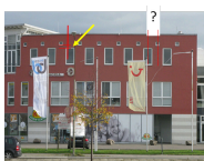
Fig. 112: Зображ. Фасад будівлі на вулиці Ратцебургет аллее в Любеку..... 210
