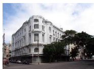
Fig. 21: ""Зображ. будівля станом на 2008 рік; архітектори Lopes and Valadares, 2008"" ..... 57
